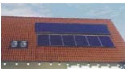
6 yksikköä asennettu katon päälle (+PV)
