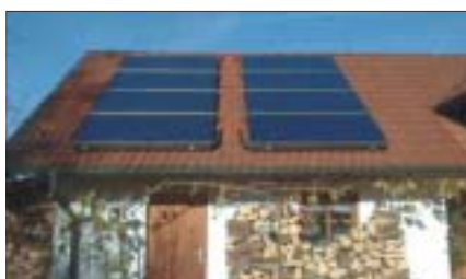
Keräimet kiinnitetty vaakatasoon päällekkäisesti
