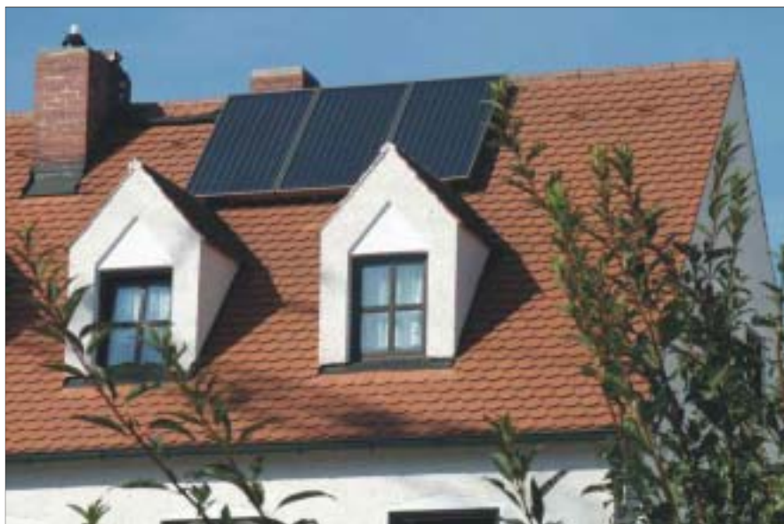
3 yksikköä asennettu katon päälle kiinni toisiinsa
