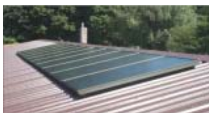
Asennus kattoruuveilla
