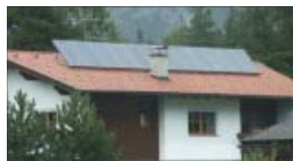
Korotettu asennuskulma
