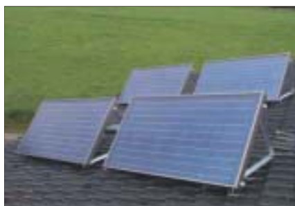
Asennettu vinosti lappeen suuntaan nähden
