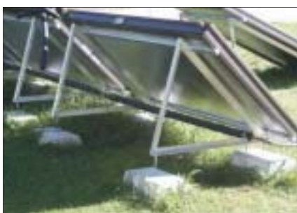
Asennus telineille maahan
